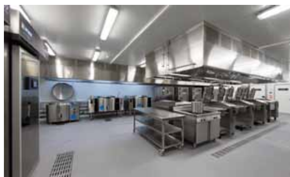
Cocina central de Serunion en S. Fdo. de Henares (Madrid).
